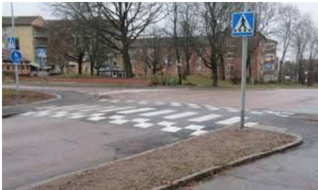
Figur 5: Ett mindre platågupp vid övergångsställe. (Västerås stad, 2016)
